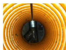
Montagestang fastgøres på brønden med den medfølgende clips
