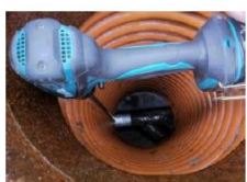
Stil momentet på 7 og placer rottespærre. Træk op i stangen og spænd til momentet slår fra
