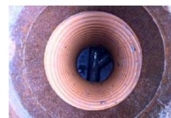
Installer rottespærre i en egnet og klargjort brønd som eks.
