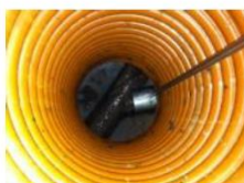
Vælg hvor rottespærre skal monteres og vurder om der er uhindert plads ved flere løb i brønden
