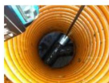
Vælg hvor rottespærre skal monteres og vurder om der er uhindert plads ved flere løb i brønden
